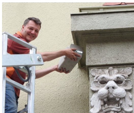
Abb. 33: Franco Cassese beim Einbau einer Mauersegler-Nisthilfe in der Werderstraße. Foto Dagmar Uttich.
