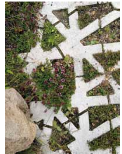
Mit speziellen Samenmischungen lassen sich Rasengittersteine sehr gut bewachsen.
