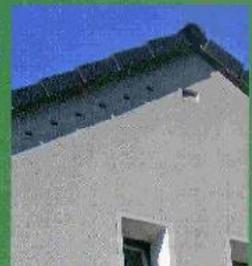
Diese Nist-Einbauskästen werden nach dem Einbau zusammen mit der Fassade verputzt. So sind nur noch die abnehmbaren Einflugschellen sichtbar.
