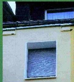
Der Mauersegler-Nistkasten kann bestandswährend einer Fassadendämmungsmaßnahme in die Dämmung eingebaut werden. Für den bündigen Einbau kann die Bauteile mit dem Einflugschell ausgetauscht werden.
