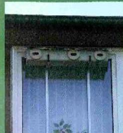
Nachträglich montierter 3-fach Mauersegler-Nistkasten. Die runden Einflugschellen mit Langloch-Öffnung können zur Reinigung und Kontrolle einfach abgenommen werden.
