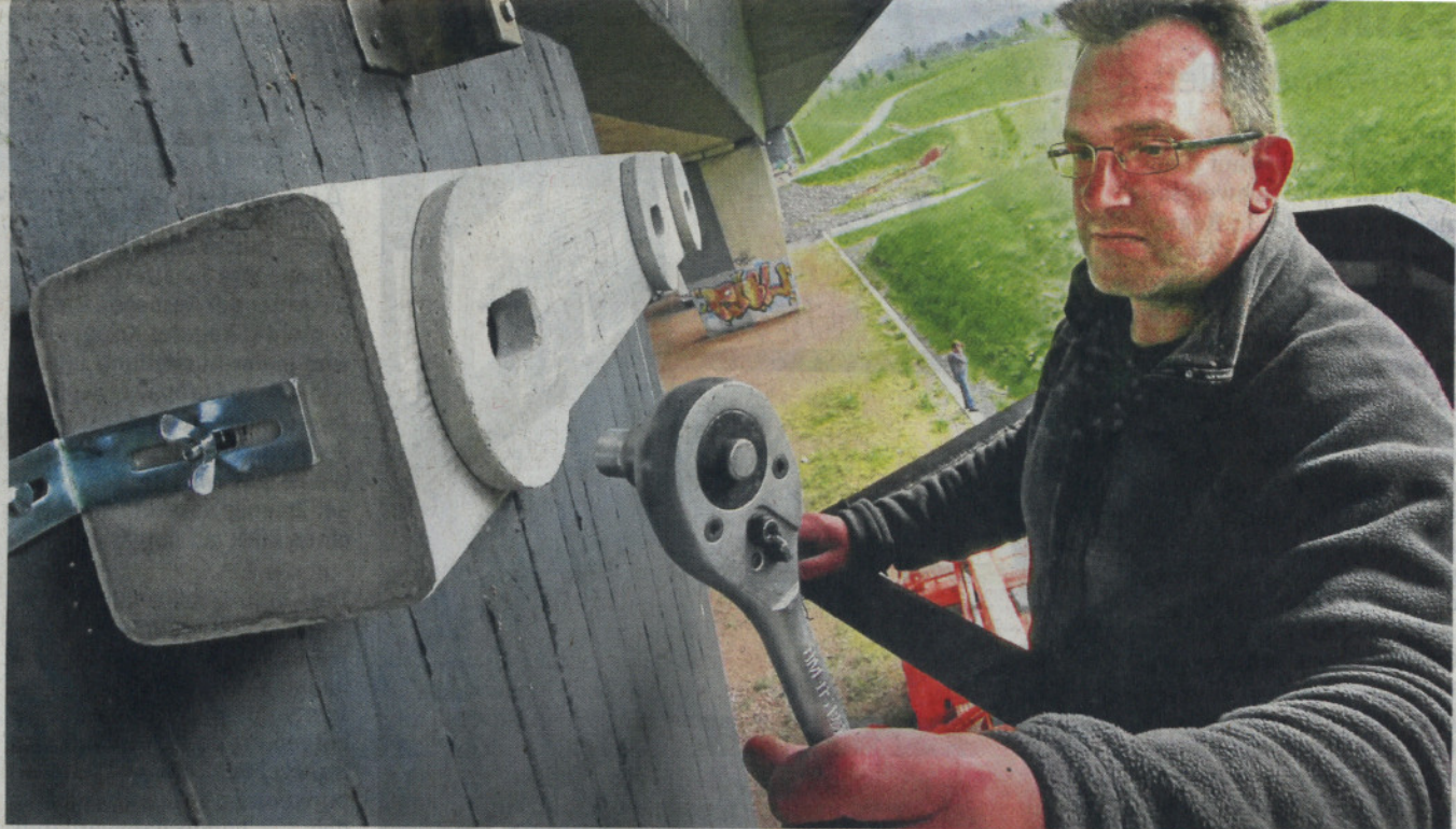
Gerd Ratzlaff vom Tiefbauamt schraubt die Nistkästen für die Vögel am Stützpfiler der Brücke fest.
